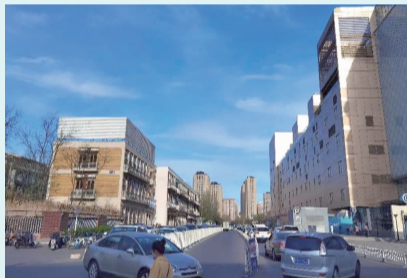
茂兴中路改造前
